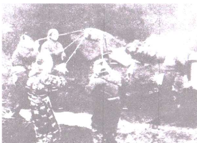
タコつき風景。これで、ローラーのまわれない所をつきかためた。6人用のタコである。
